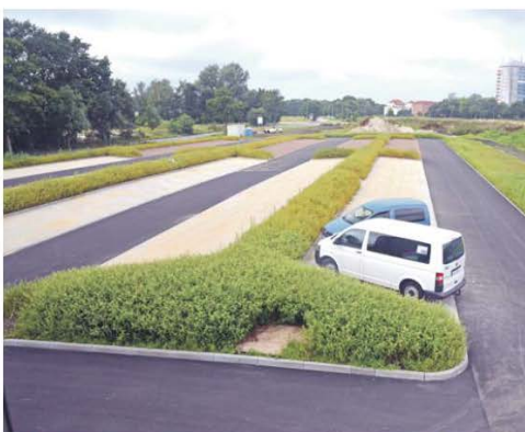
120 Stellplätze stehen neben der Wache zur Verfügung. 60 sind gepflastert und breiter, damit die Feuerwehrleute im Einsatzfall mit ihren Privatwagen nicht lange rangieren müssen.
