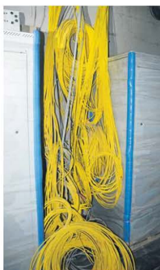
Moderne Technik: Eine Unmenge von Kabeln muss in dem Neubau verlegt werden.
