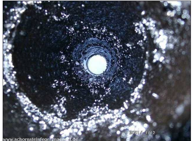
Glanzruß im Schornsteinrohr
